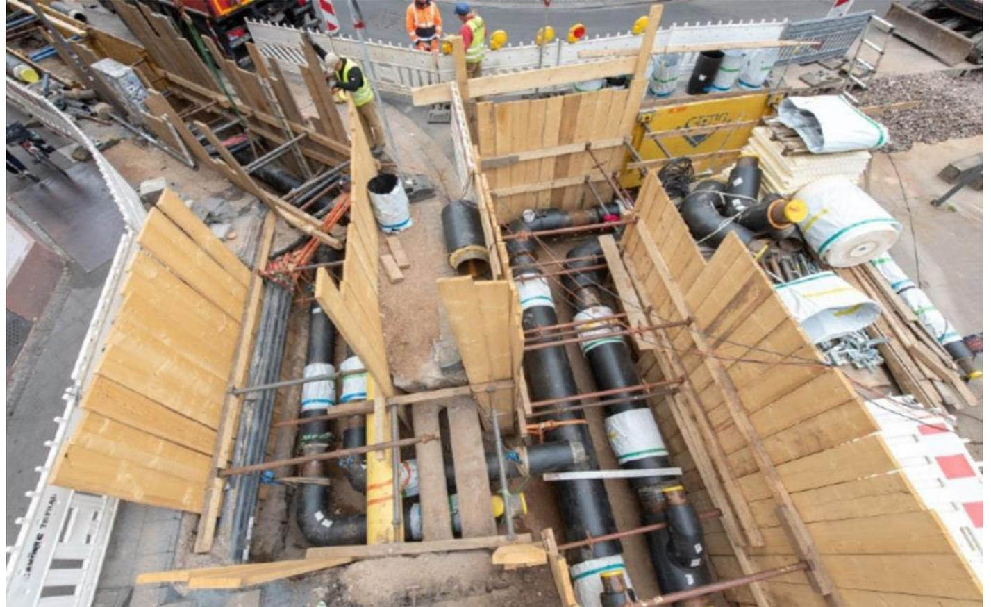
Erdverlegte Wärmeverteilung über ein Kunststoffmantelrohrsystem,
